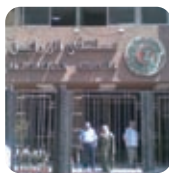
El Zerayeen Hospital 560CH (Egypt)
